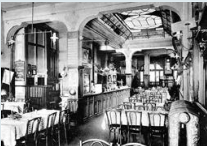
Innensicht (1912). Das schöne Oberlicht verschwand durch eine Bausünde nach dem Krieg.
