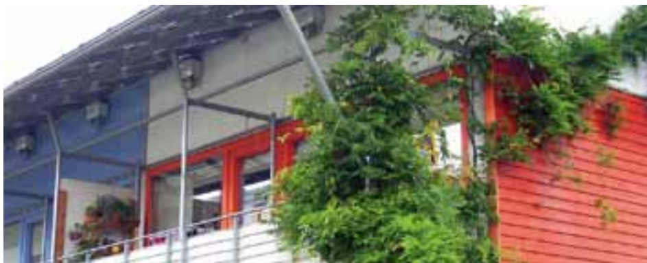
Die Solarsiedlung im Freiburger Stadtteil Vauban zieht Öko-Touristen an.
